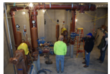
Extension de la station d'épuration de la série PE, nouvelles pompes de recirculation du digesteur
